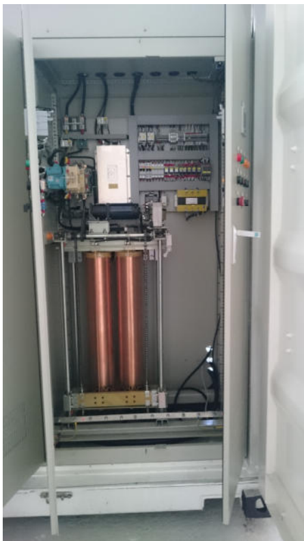
Шкаф регулятора напряжения автотрансформаторного с защитами от КЗ и перенапряжений АВВ
