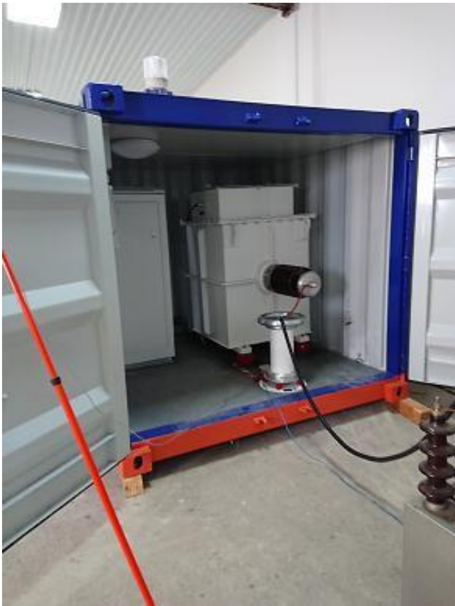
Сигнальная лампа при проведении высоковольтных испытаний
