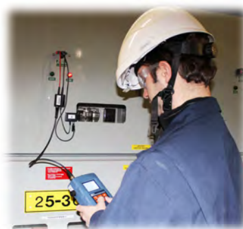
Переходник в работе с распределительным устройством и прибором XDP-II™
