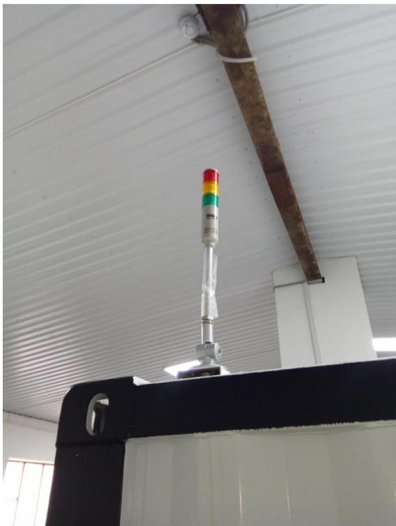
Сигнальная мачта при проведении высоковольтных испытаний
