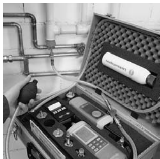
Проведение основного теста с использованием прибора testo 312-2/3
