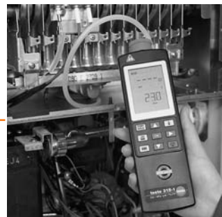
Испытание на герметичность с помощью testo 312-1/2
